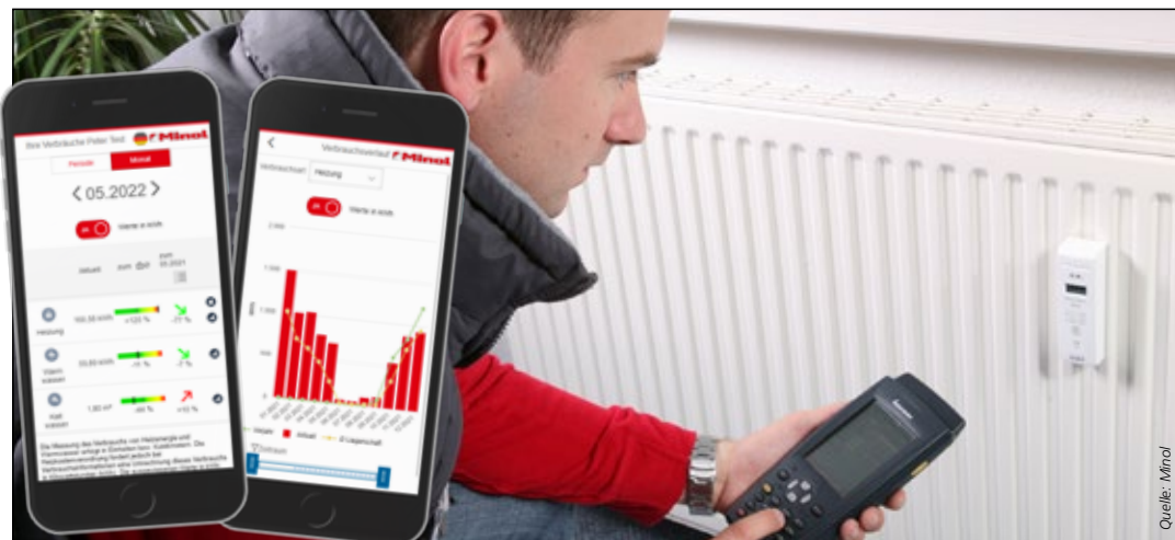
Hier kommt der Ableser noch in die Wohnung – ein Funknetzwerk macht dies überflüssig
