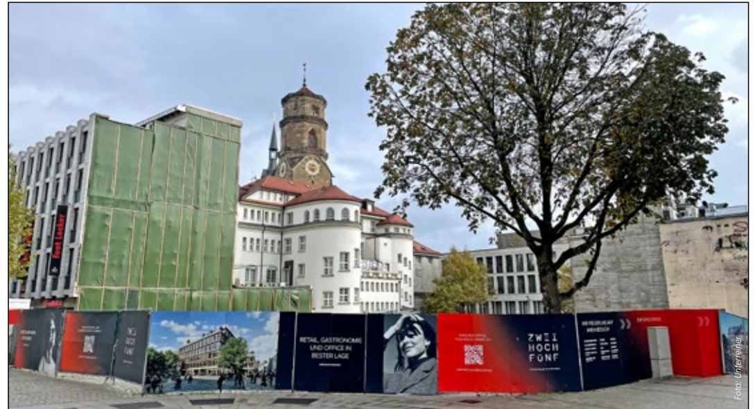
Große Ungewissheit: Wie lange ruht die Baustelle?
