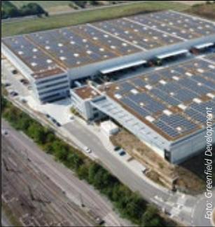
etwa 3,6 GWh. Laut Greenfield handelt es sich damit um eine der größten PV-Anlagen auf einem Industriedach in der Region Stuttgart. Der Strom dient zuerst dem Betrieb des Prototypenwerks mit 48 000 m<sup>2</sup> Nutzfläche plus dazugehörigem Bürogebäude; überschüssigen Strom vermarkten die Stadtwerke Waiblingen an andere Verbraucher.
