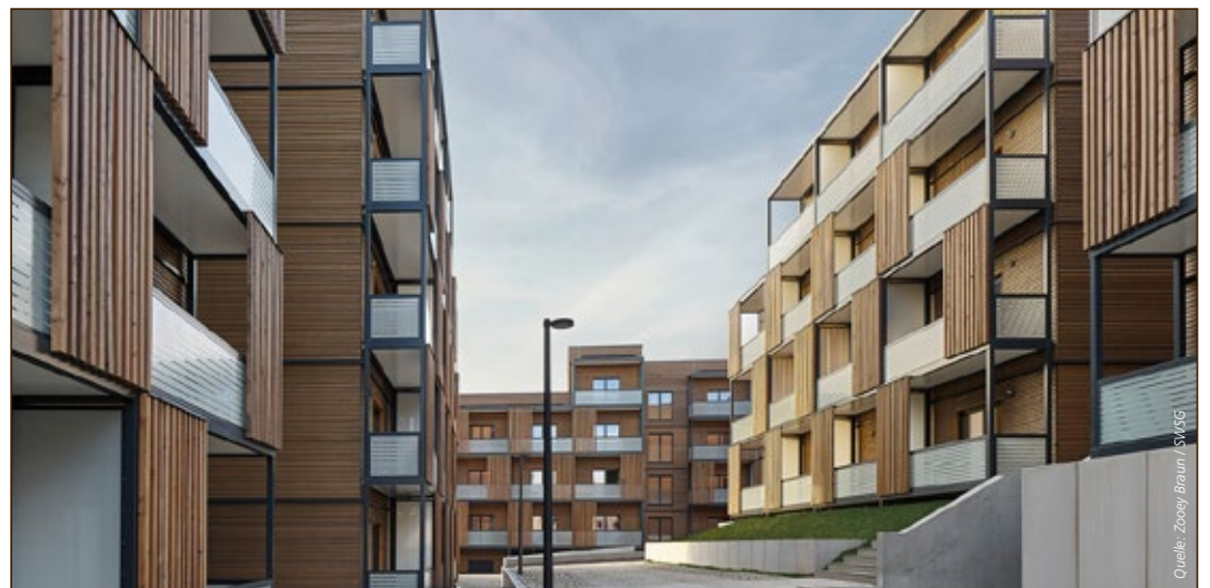
Im Prießnitzweg kommt ein zweiter Bauabschnitt
