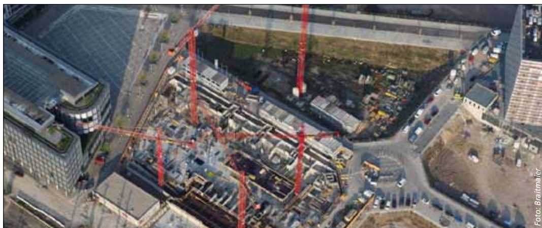
In Stuttgart wird fleißig gebaut – aber nur wenig Eigentumswohnungen
