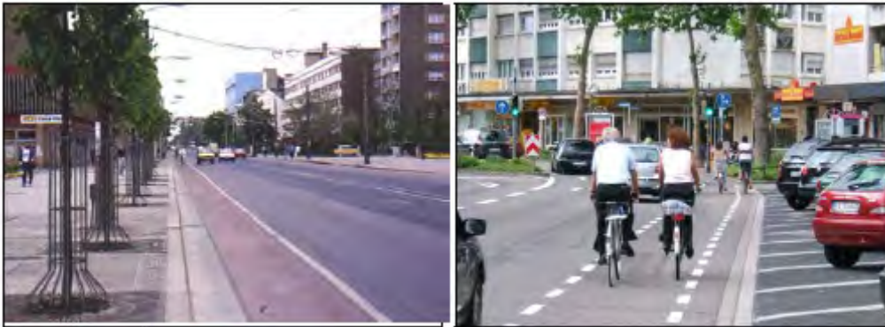
Abbildung 7: Überbreite Richtungsfahrstreifen, die früher zweistreifig markiert waren, mit daneben liegenden Radfahrstreifen (links Dessau) bzw. Schutzstreifen (rechts Karlsruhe)
